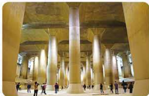
世界に誇る巨大地下神殿「首都圏外郭放水路」
